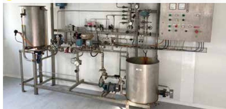
Montage-Gestell im neuen Schulungscontainer
