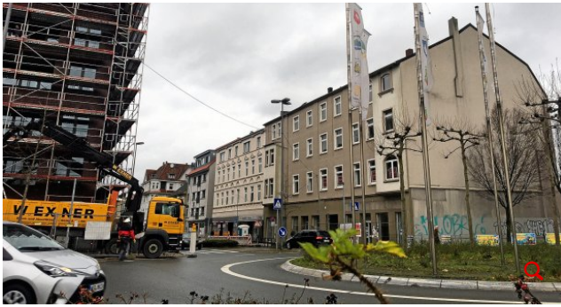
Links ist der Bau des K111 schon weit fortgeschritten, der Abbruch des Hauses gegenüber hat begonnen. Foto: Bolsmann
